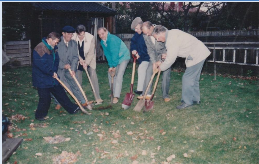
Första spadttaget av husföreningens styrelse och intendent
