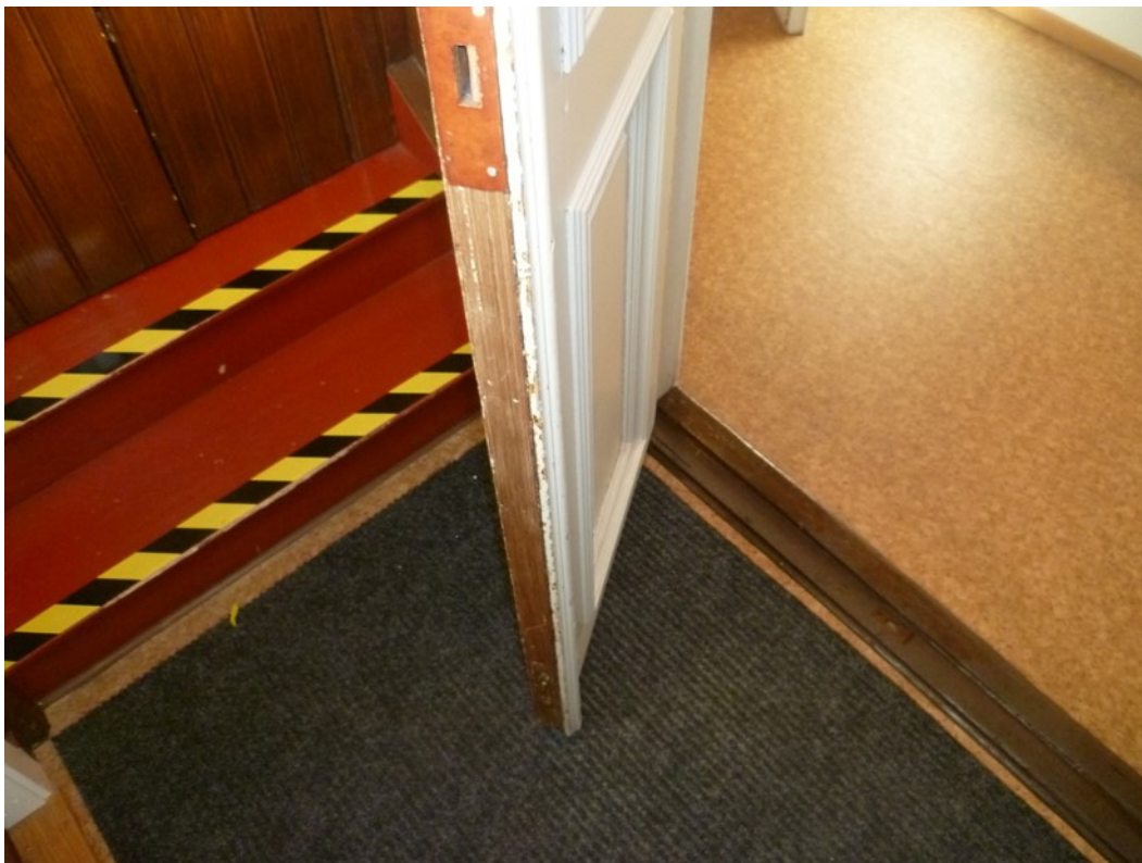
Underhållspluton Alfredsson/Linnarssons iordningsställande av entré!
