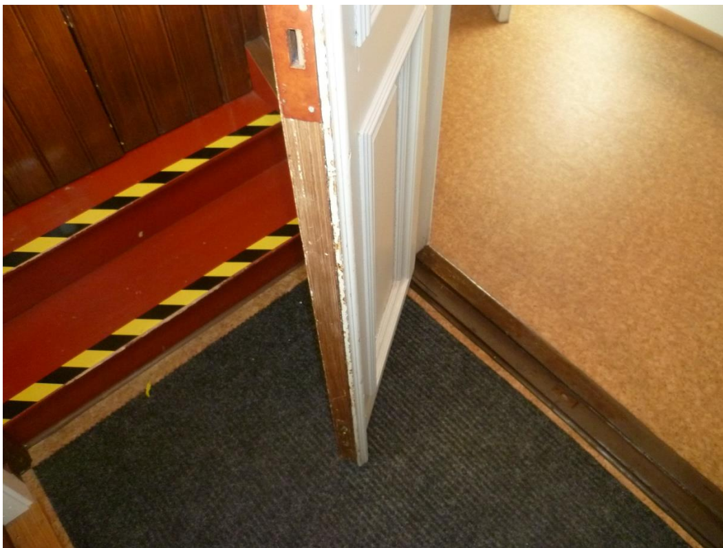
Underhållspluton Alfredsson/Linnarssons iordningsställande av entré!
