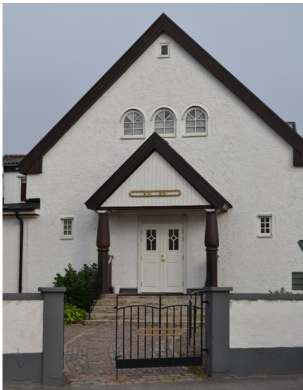
Logehuset med sin nya entrédörr
